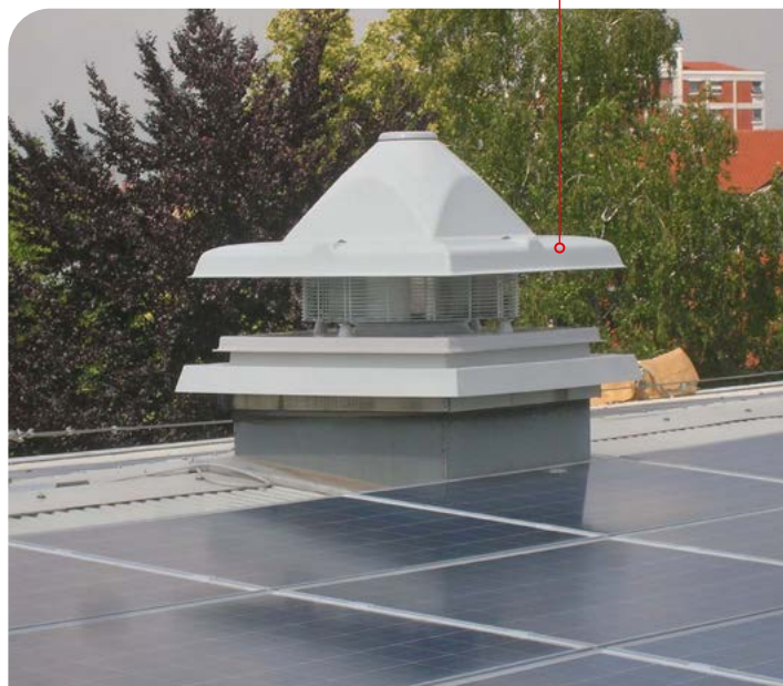
Estrattore centrifugo su basamento in vetroresina
