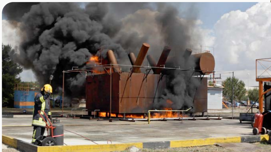
Test sperimentazione trasformatore elettrico – Accensione
