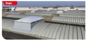
a Caoduro® ha completato nel 2024 l'installazione di un sistema di evacuazione naturale di fumo e calore in un importante stabilimento industriale in provincia di Cremona. Questo intervento è parte della riqualificazione di tre capannoni rimasti incompiuti, ora utilizzati come magazzino dalla nuova proprietà.
