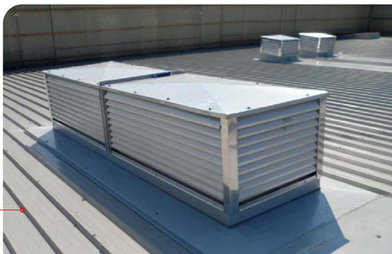
Aeratore AN modulare con coperchio in alluminio su basamento Coverlink in vetroresina
