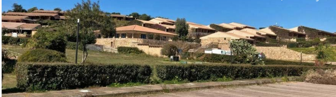
Esterni del Residence Porto Mannu, Palau Sardegna
