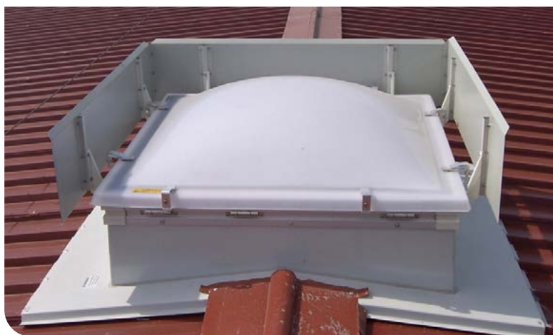
Coverlink a cavallo del colmo con ENFC
