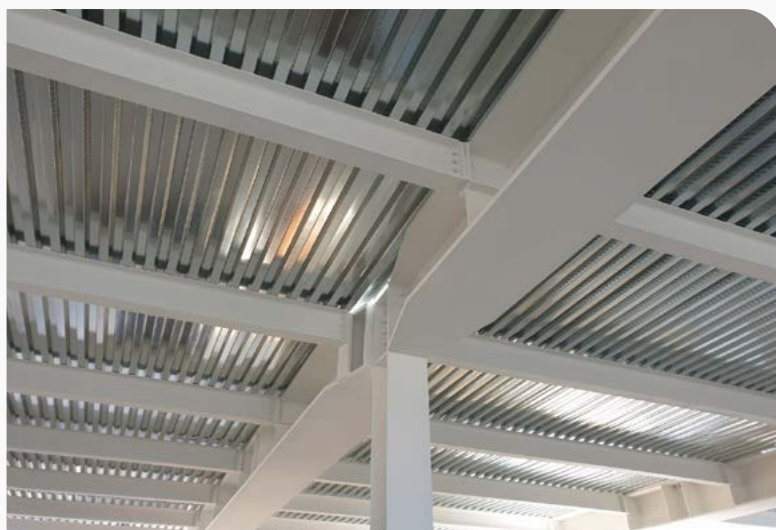
Travi in acciaio protette con vernice intumescente
